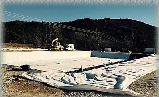
Les deux bassins ont été creusés puis recouverts d'une membrane étanche en « sandwich » entre deux géotextiles. Des drains de fond de bassin ont été installés puis des couches de matériaux de lestage ont été mises en place.
